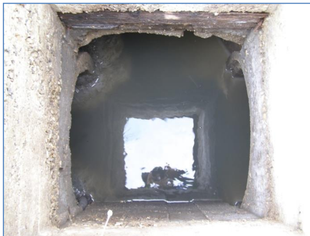
Slika 44 Šaht 52, normalan tok vode(lijevo); Šaht 54 na ispusnom kolektoru (desno) - vidljivo je da voda stoji, nešto nizvodno radi uspor
