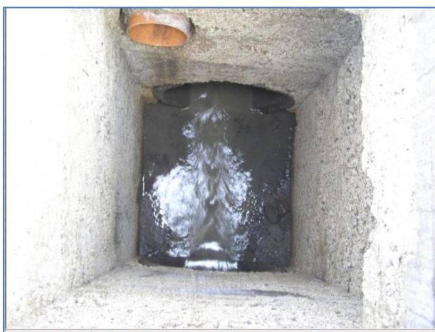
Slika 44 Šaht 52, normalan tok vode(lijevo); Šaht 54 na ispusnom kolektoru (desno) - vidljivo je da voda stoji, nešto nizvodno radi uspor
